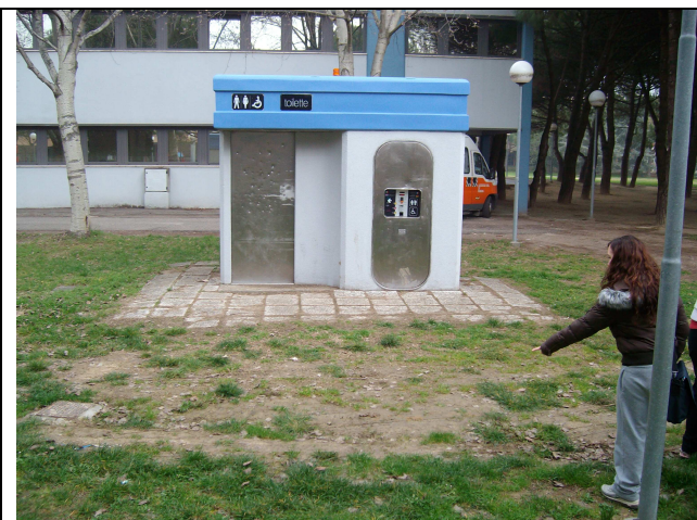
Bagno pubblico dietro al comune con terreno disconnesso
