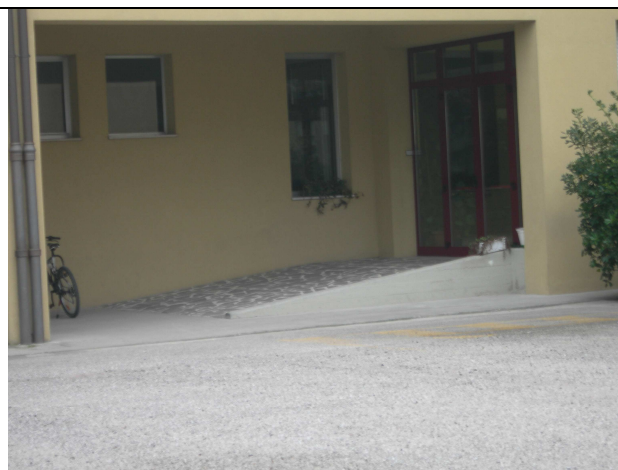
Rampa per accedere a scuola
